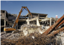
Beim Rückbau der Zigarettenfabrik mussten 85.500 Tonnen Betonschutt und Altlasten entsorgt werden Foto: DIE WOHNKOMPANIE Berlin
